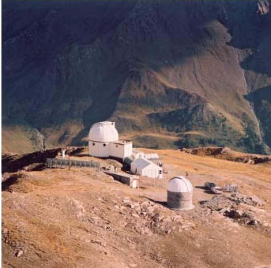
La station à l'approche de l'orage : un petit air de Mars !
